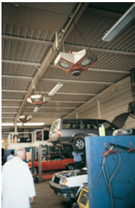
2. Réacteurs thermo-catalytiques étudiés pour le chauffage des locaux présentant un risque d'atmosphères inflammables ou explosives
