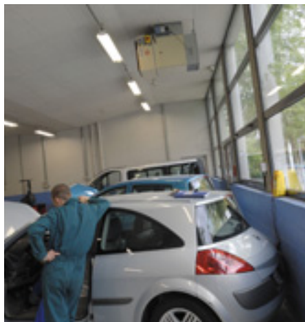
3. Chauffage par aérotherme
